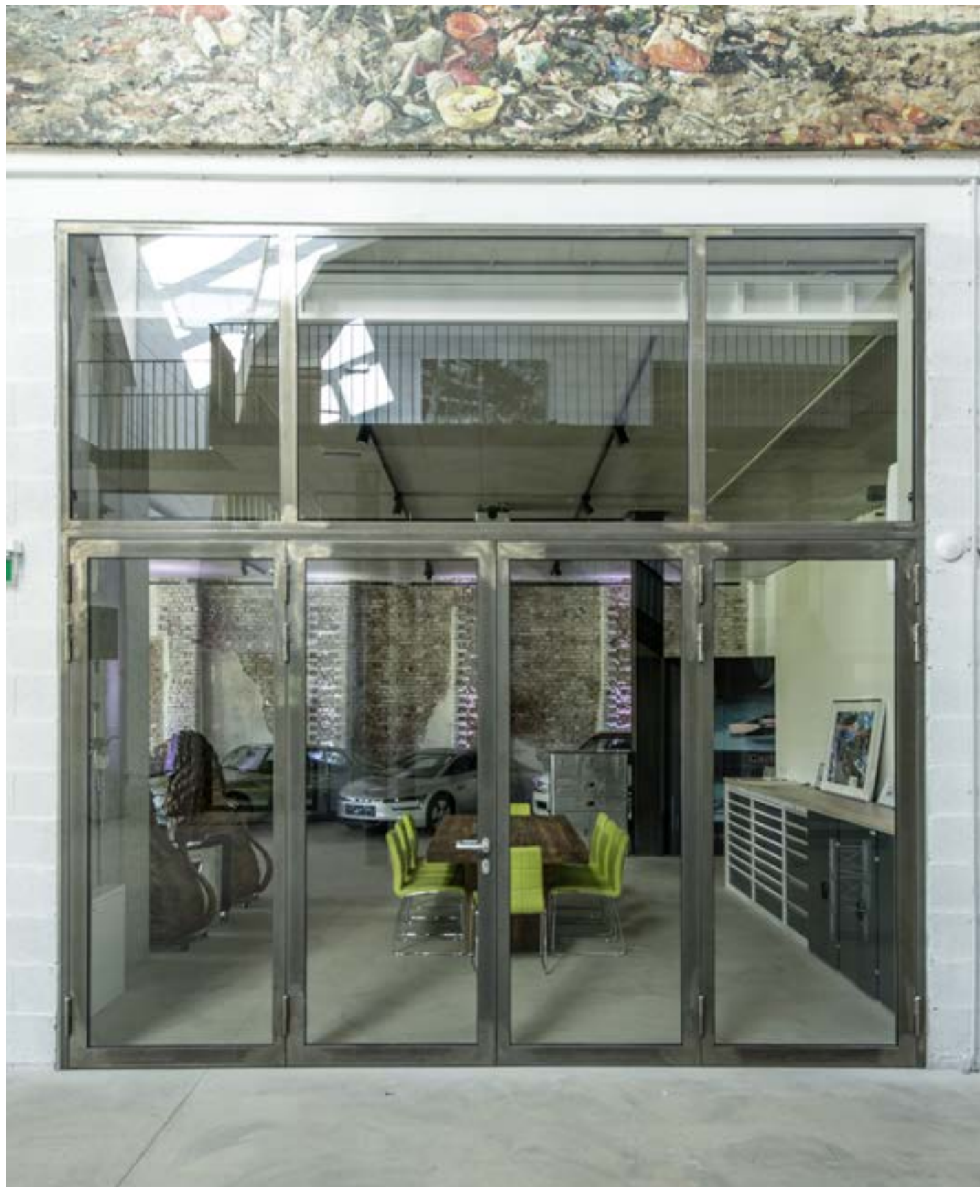
Panzerhalle, Salzburg/AT (Architekt: ARGE LP Architectur/CS-Architektur/Strobl Architekten)
