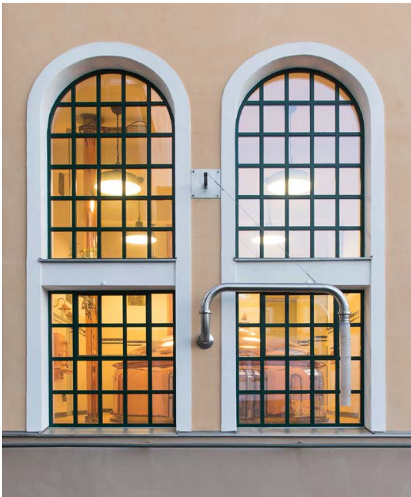
Augustinerbräu-Sudhaus, Salzburg/AT (Architekt: Bmst Dipl.-Ing. Helmut Hopfner)
