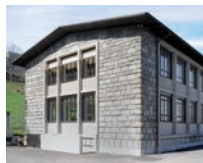
10 Pumpwerk Schönau, WVRB AG, Bern/CH
