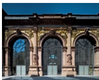
18 Renovation «Alte Post», Pirmasens/DE
