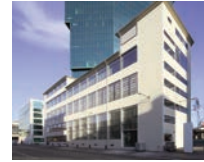
6 Umbau Bürogebäude «Diagonal», Zürich/CH
